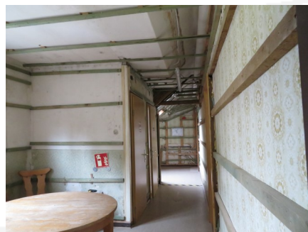
Entfernung der Möbel und der Holzverkleidungen in den Fluren
