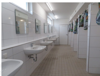
Blick in die neuen Duschen
